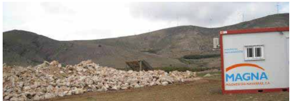
Extracción de prueba (Abril/2012). Al fondo se observa la ladera del Tablado a destruir
