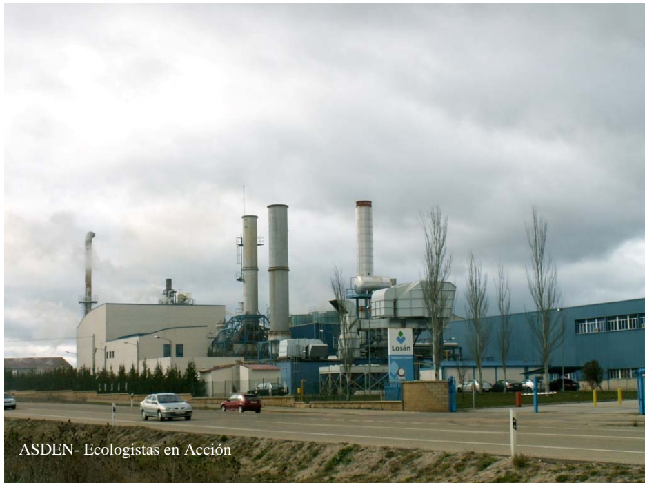
Fotografía 1: Vista general de la instalación
