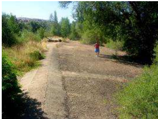
Losa de hormigón junto a la presa
